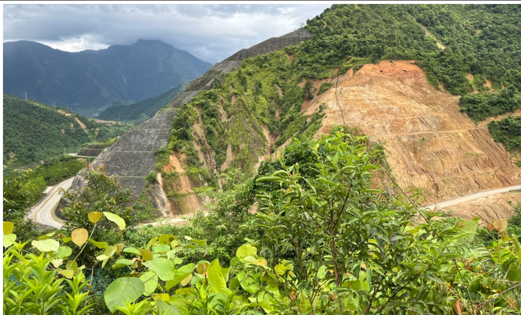
Hình 2-3: Khu vực mái cửa lấy nước đang bị sạt
