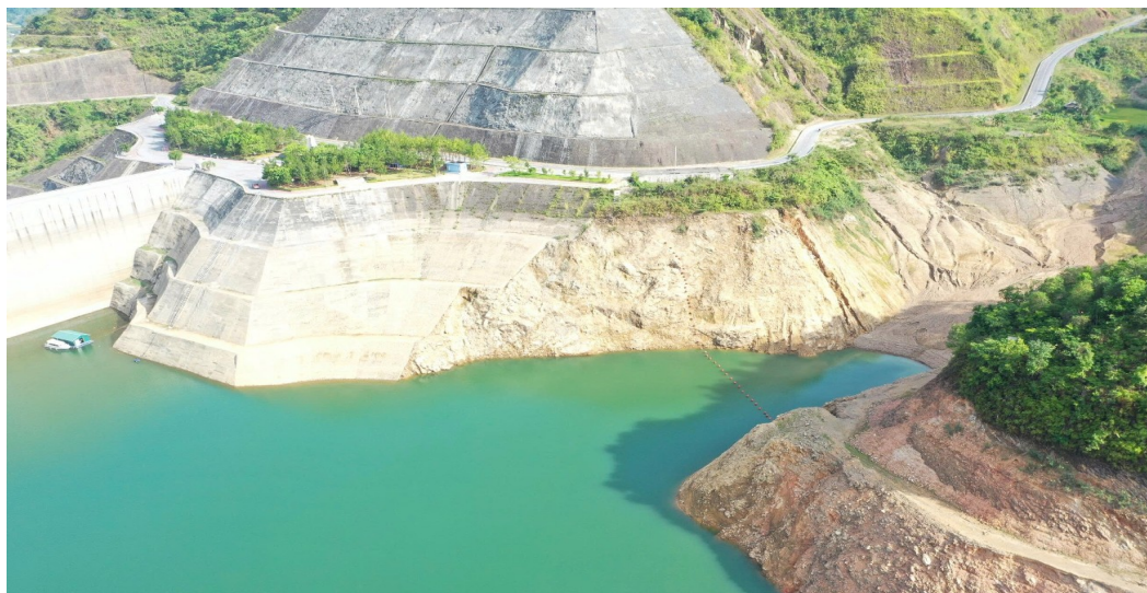
Hình 2-2: Hiện trạng bồi lắng tại vị trí dự kiến đặt cửa lấy nước
